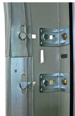
A l'aide de boulons M8 et de 2 equerres de maintien , fixez le profil C derrière le rail horizontal
