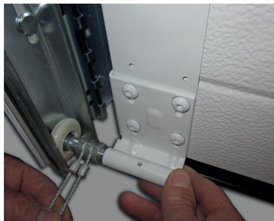
3 - Positionner le panneau inférieur en introduisant la roulette dans la console de base
