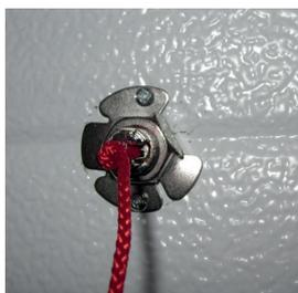
Attacher la cordelette au chariot de l'actionneur
